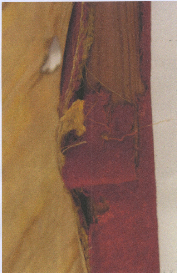
Bild 3. Strumpan fäst mot sången med sekundär spik y.s.
